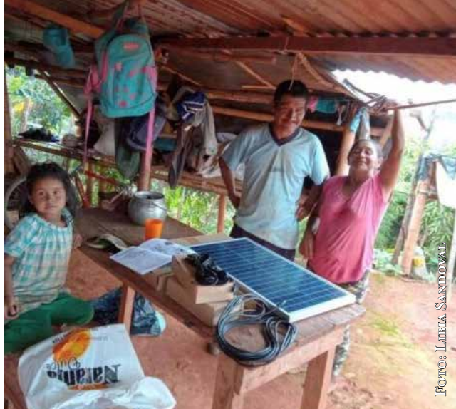
Las celdas fotovoltaicas permiten captar la energía solar y son instaladas en los sitios no interconectados a la red eléctrica.
